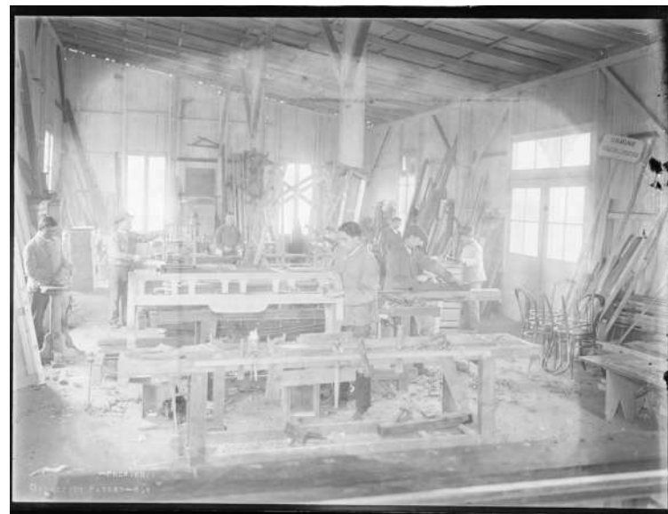
Dirección General de Paseos Públicos. 1919. Corralón del Parque. Carpintería. CIAPoteca UNSAM-CONICET.
