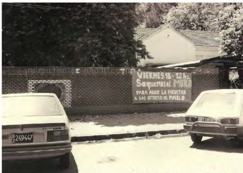
Fotos demolición del Muro FAU UNLP - 1994
