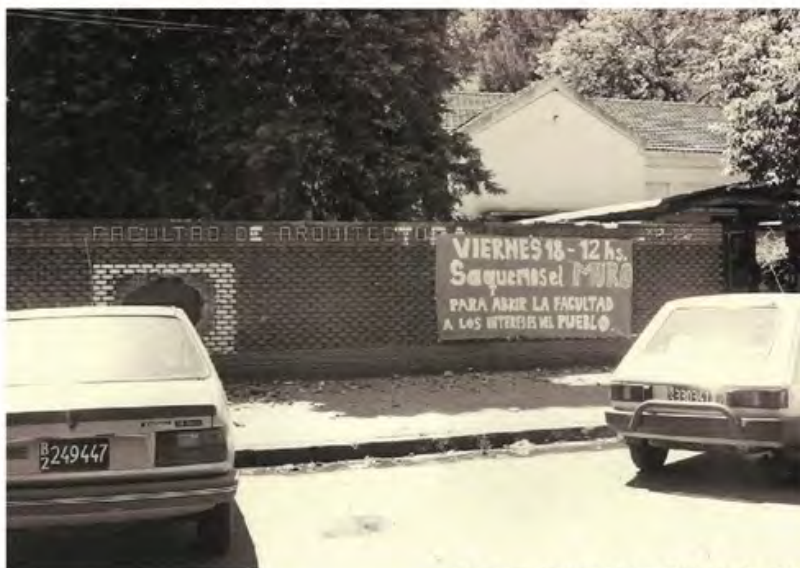
Fotos demolición del Muro FAU UNLP - 1994
