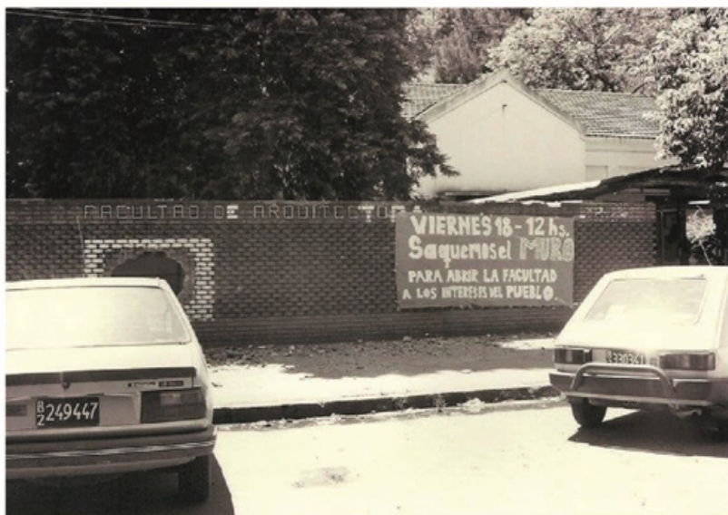
Fotos demolición del Muro FAU UNLP - 1994
