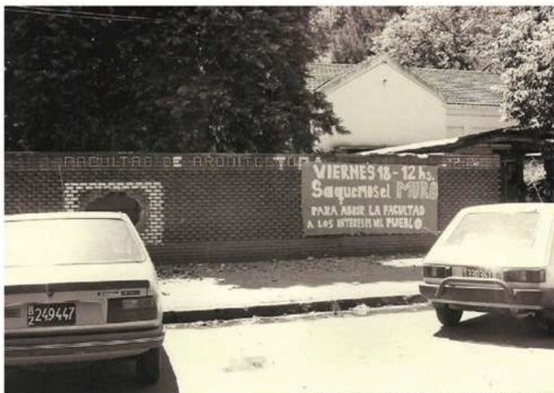
Fotos demolición del Muro FAU UNLP - 1994
