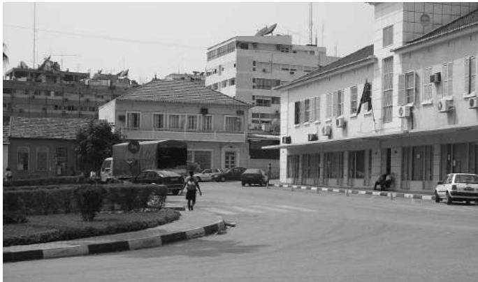
Figura 74 Edificación tradicional. Patrimonio arquitectónico
