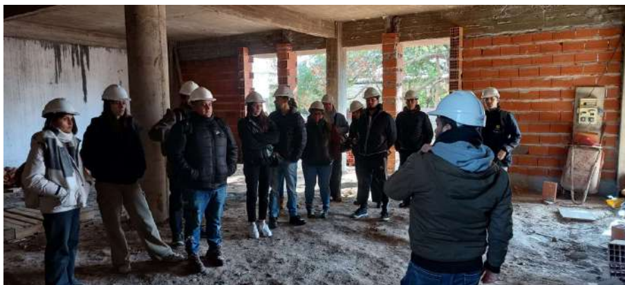
Ilustración 8_ "día de obra"
