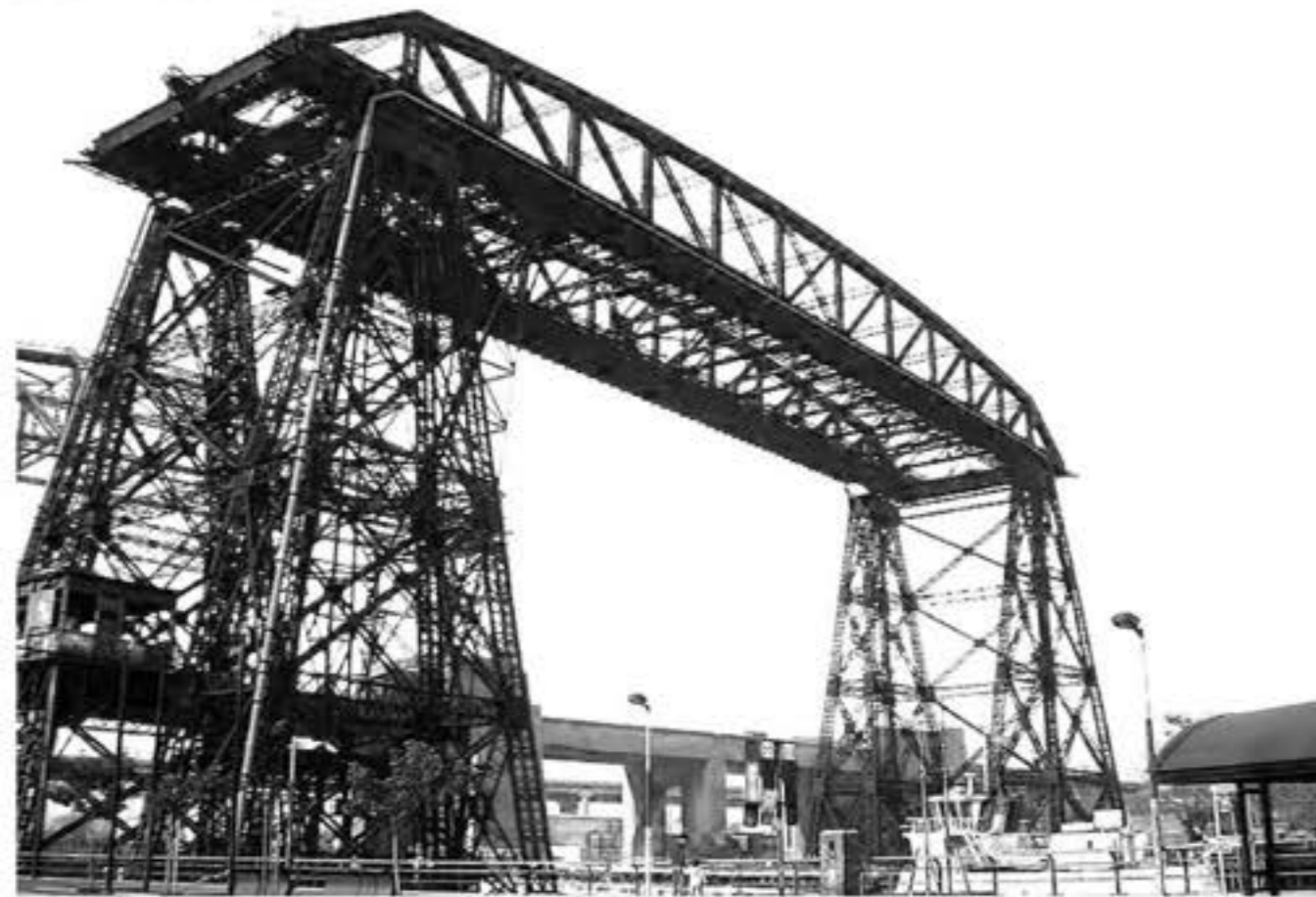
Puente Transbordador Nicolás Avellaneda, barrio de la Boca, en la Ciudad Autónoma de Buenos Aires. Su estructura de hierro fue inaugurada en 1914 cruzando el Riachuelo para unir con la zona sur del Gran Buenos Aires.
