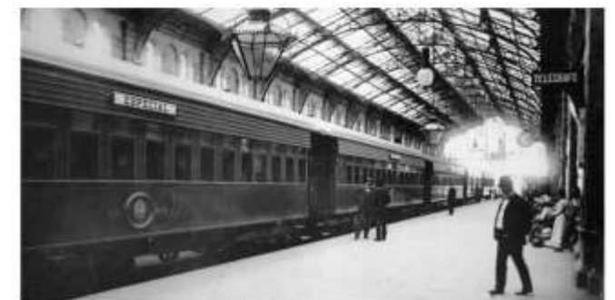
Construcción metálica: Andén de la estación Constitución
