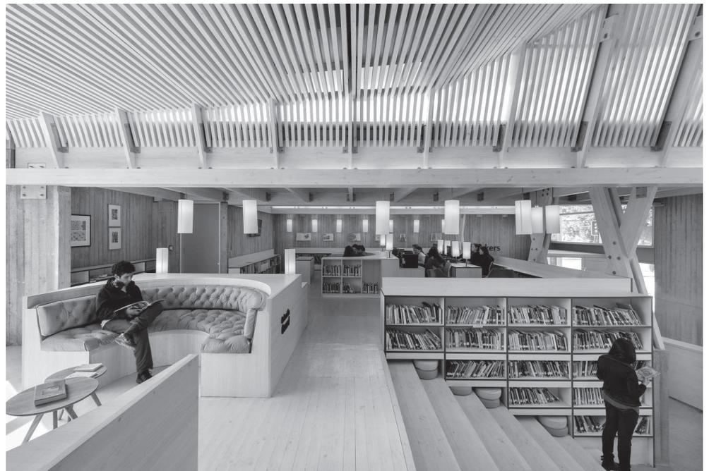
En cuanto a la construcción del edificio, es hecho casi completamente en madera y sólo los cortafuegos son hechos con hormigón expuesto vertido. La estructura es prefabricada y es hecha de pino laminado. Para acentuar el ritmo del espacio interior, las cargas y el proceso de construcción comprensible, los rayos de la madera y los pilares, son mantenidos tan visibles como posible.
