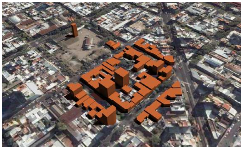
Aplicación sobre un caso. Un sector del área centro de la ciudad de La Plata, considerando el reemplazo progresivo de edificios que fueron evaluados por su estado. Manzana comprendida entre calles 3/4/45/46. Área centro La Plata.
