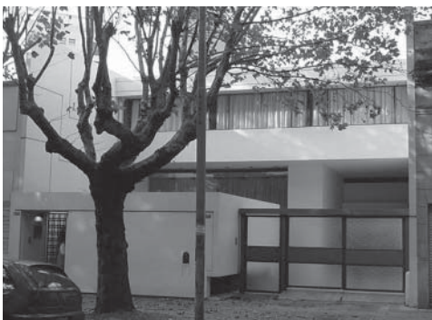
casa en dg 73 entre 8 y 9
