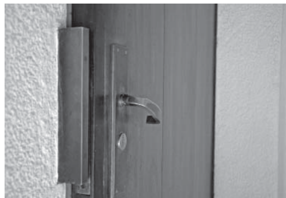
Detalle casa Sosa
