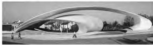
Modelado paramétrico de estructura existente a partir de la figura geométrica de un toroide
