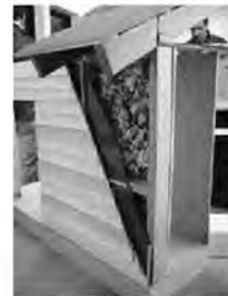
Figura 1. b. Maqueta muro compuesto
