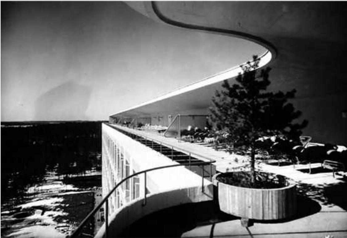
Alvar Aalto, Sanatorio antituberculoso, Paimio, Finlandia. 1929. Ejemplo de modernidad que incorpora nuevos criterios proyectuales respetuosos de la orientación de cada una de las salas, el aprovechamiento de la luz y propiedades curativas del sol para facilitar la rehabilitación de los enfermos.
