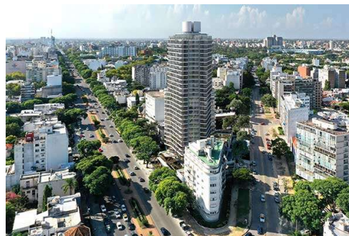
Montevideo Altura 110mts
