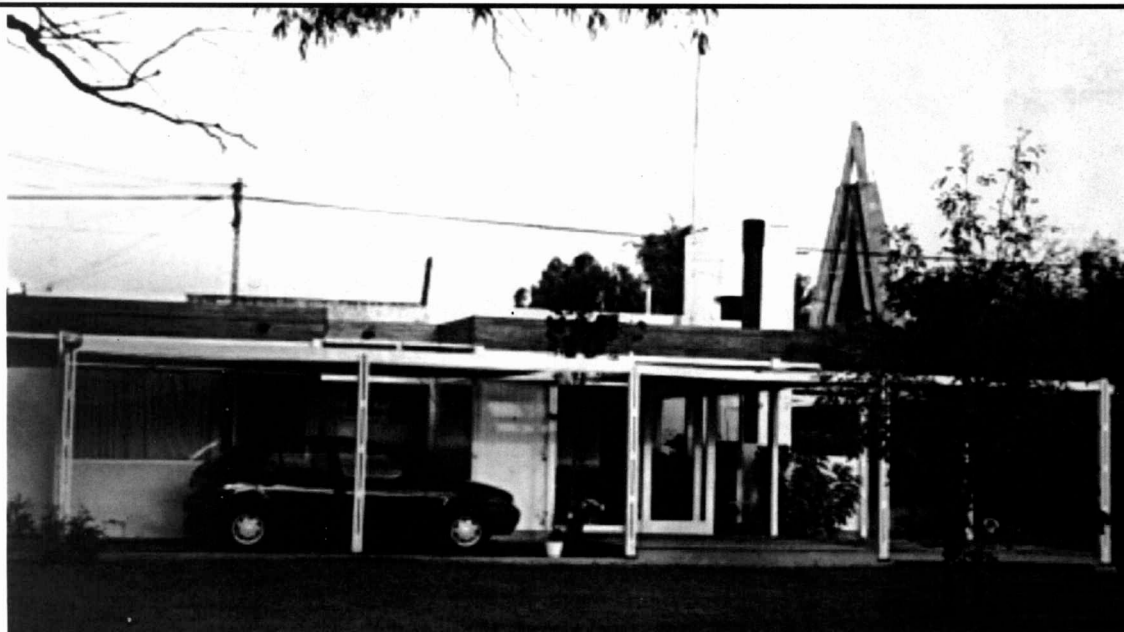
Fachada sobre calle 27
