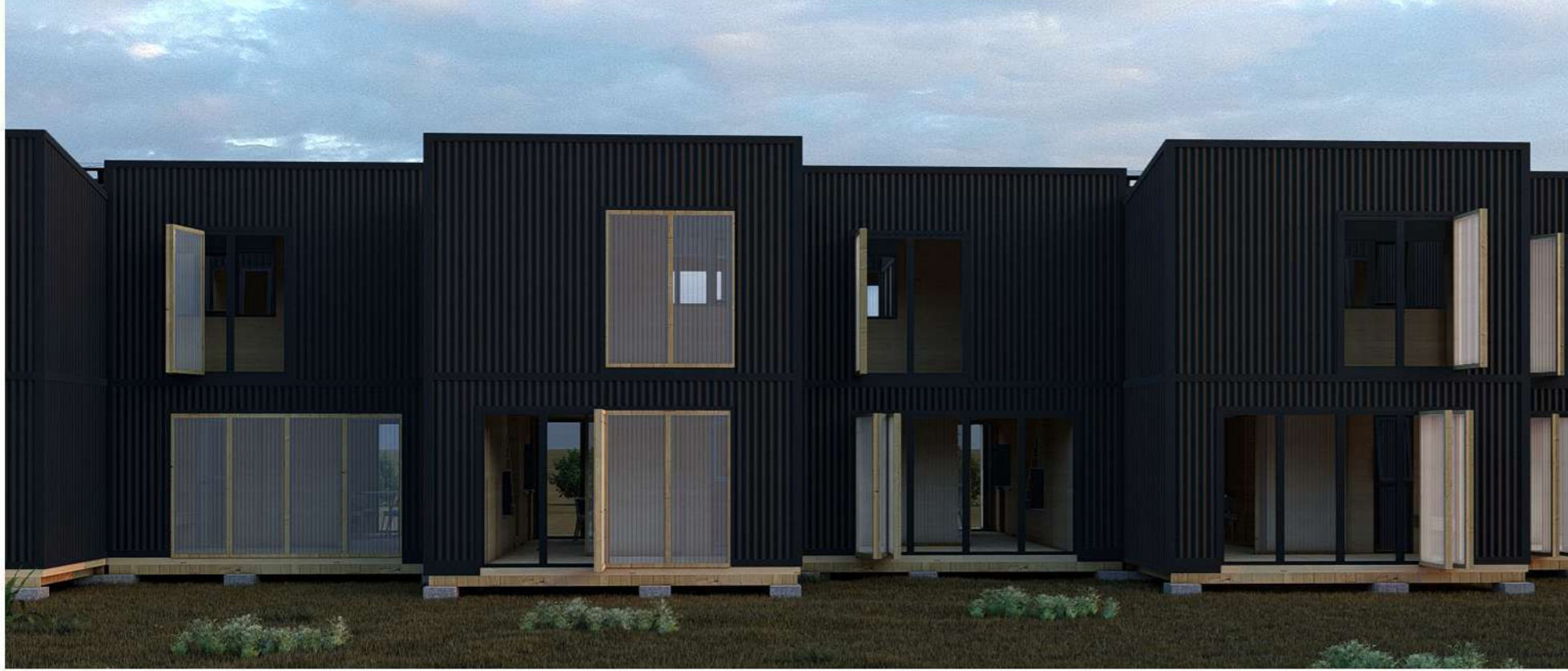
4. Vista del conjunto de viviendas asociadas · Versión diurna desde el contrafrente · Expansión hacia el espacio exterior mediante paneles plegables que funcionan como cerramiento y otorgan privacidad.
