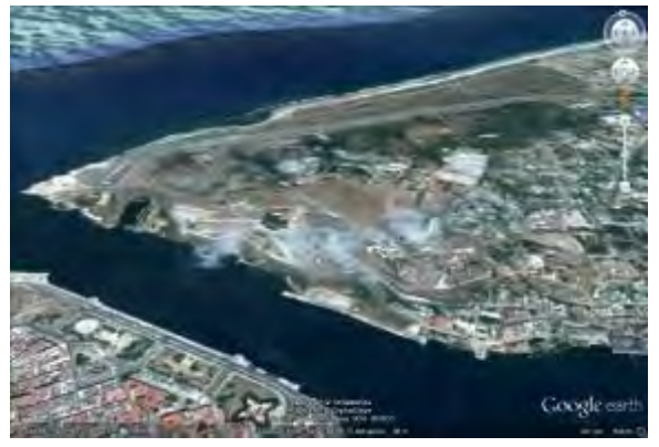
Canal de entrada a la bahía y para de trabajo
